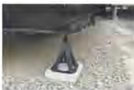
■躯体本体はジャッキを使い設置します。但し、ジャッキは工具を使わずに脱着する必要があります。
